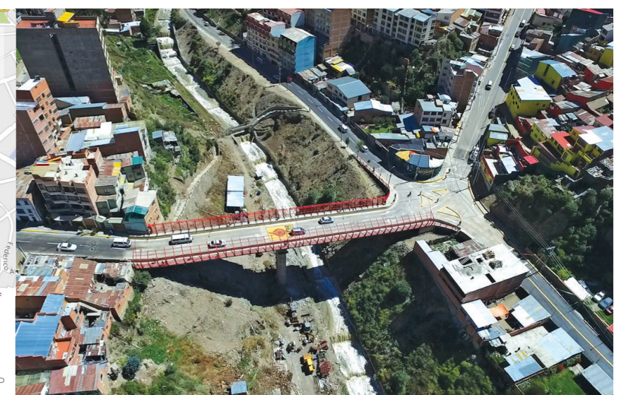
Fotografía: Puente "San Antonio de Padua". Fuente: Archivo GAMLP
