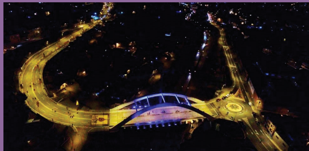
Fotografía: "Puente Integración Ferrobeni, Fuente: Agencia Municipal de Noticias, 2017
